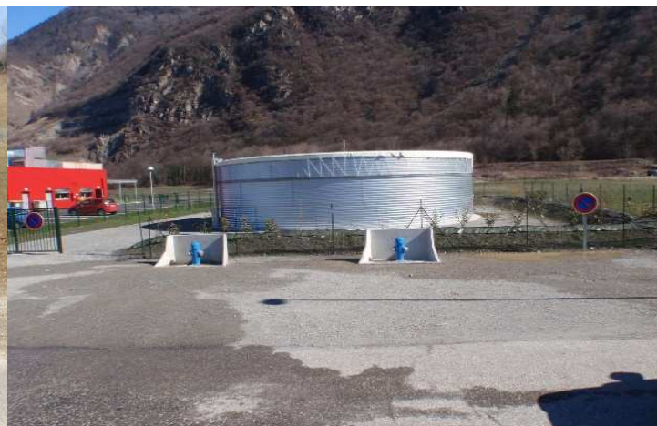
Réserve de 480 m 3 équipée de deux PA 150
