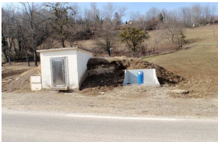
Réservoir d'eau potable équipé d'un PA 100
